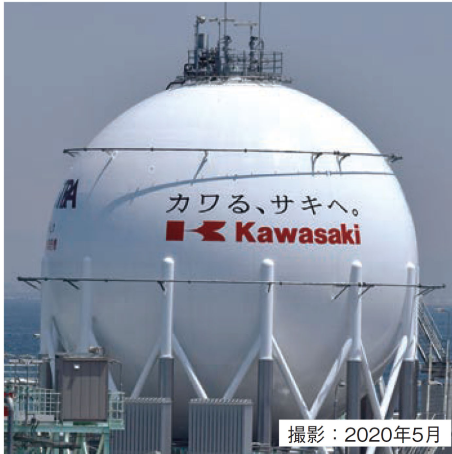
図3 液化水素タンク Fig. 3 Liquefied hydrogen storage tank
